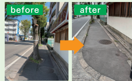
東新町 街路樹がある歩道の整備 根上りが特に激しく、通行に支障があるため整備しました。
