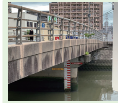
原田橋の水位計の改修 経年劣化した水位計が見にくいので改修して欲しいとの要望を実現しました。
